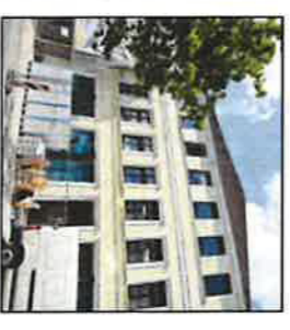
Das Medicum an der Sudstraße ist fast fertig. • Foto: Mfob
